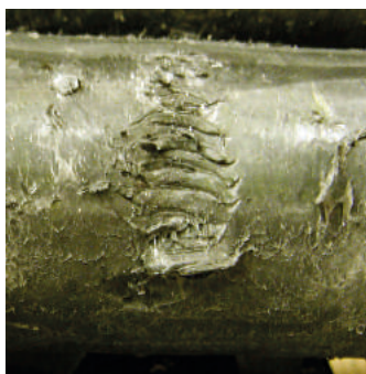
Небольшое повреждение кабеля, вызванное соприкосновением с резьбой
